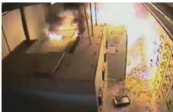
Рисунок 6.1 Взрыв ячейки УКР вследствие дугового замыкания
