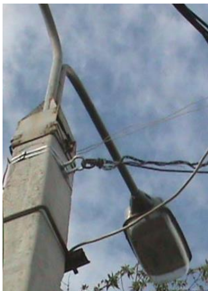
Рисунок 2.6 – Железобетонный столб
