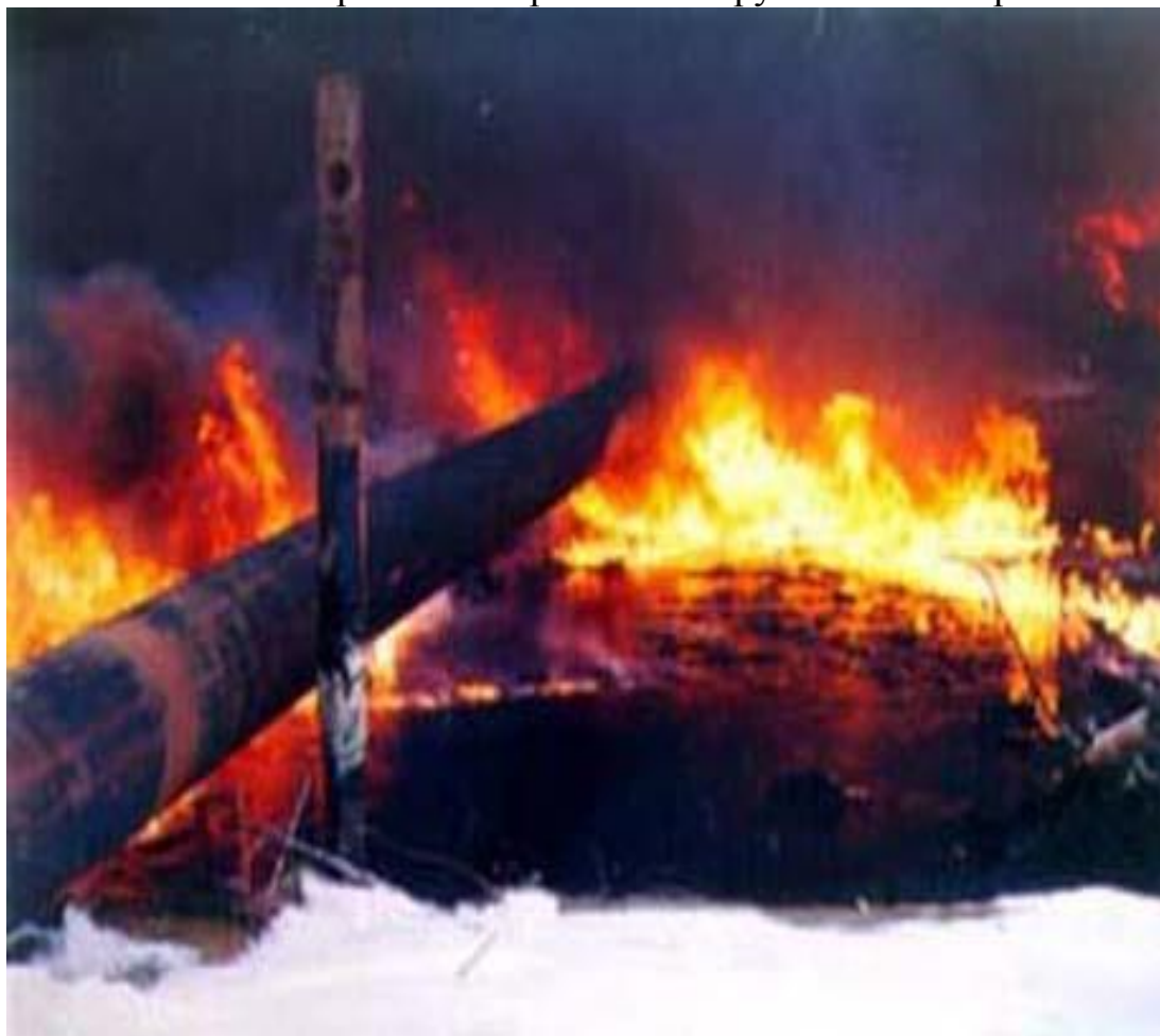
Рисунок 2.3 - Авария на трубопроводе
