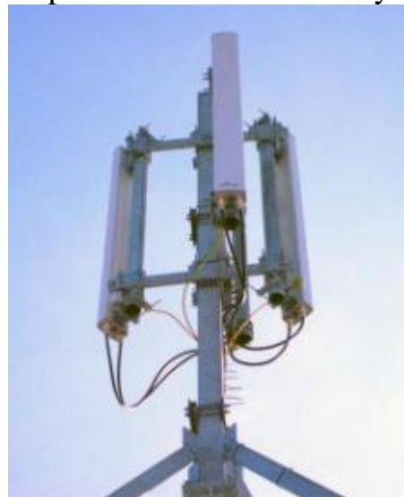
Рисунок 9 – Внешний вид секторной антенны
