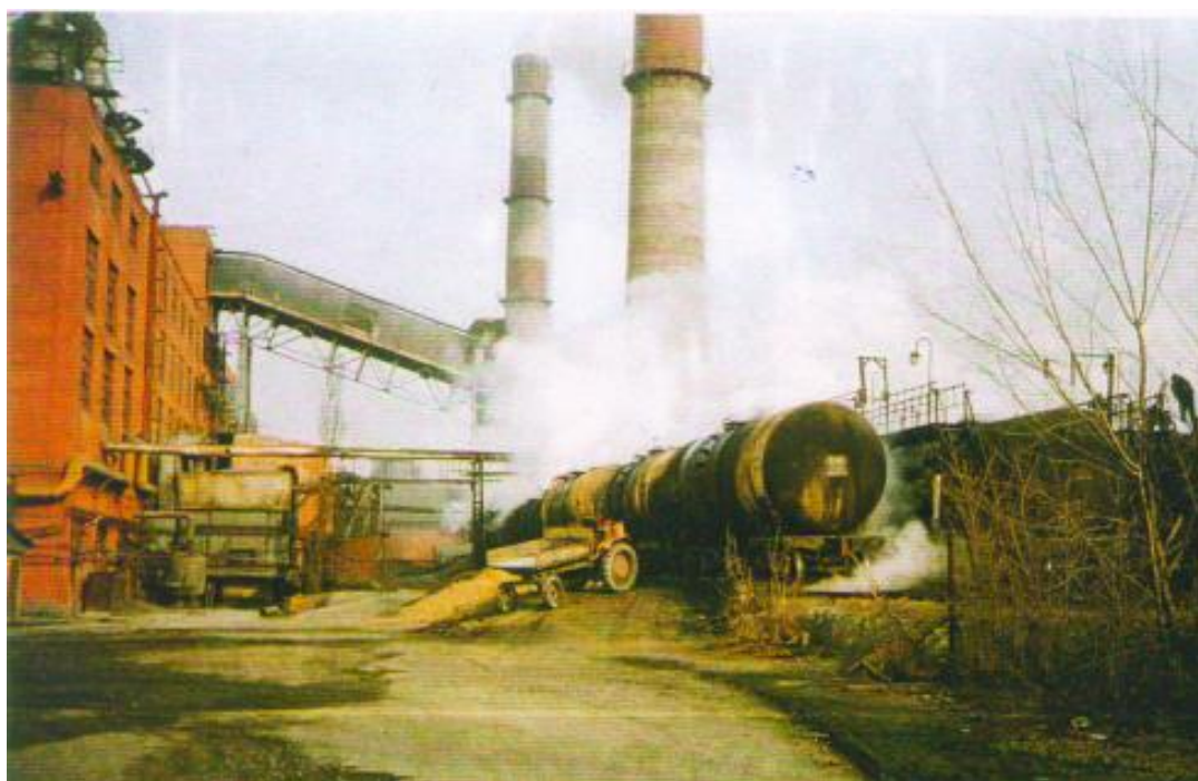
Рисунок 4.1 – Сливная мазутная эстакада
