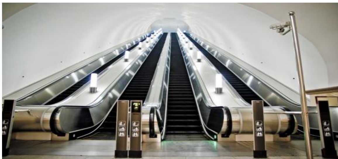
3 сурет – “Абай” бекетінде орналасқан эскалаторлар
