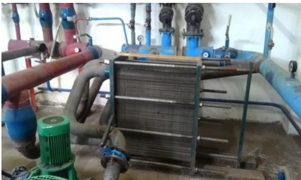
Рисунок 5.1 - Теплообменник для подогрева ГВС
