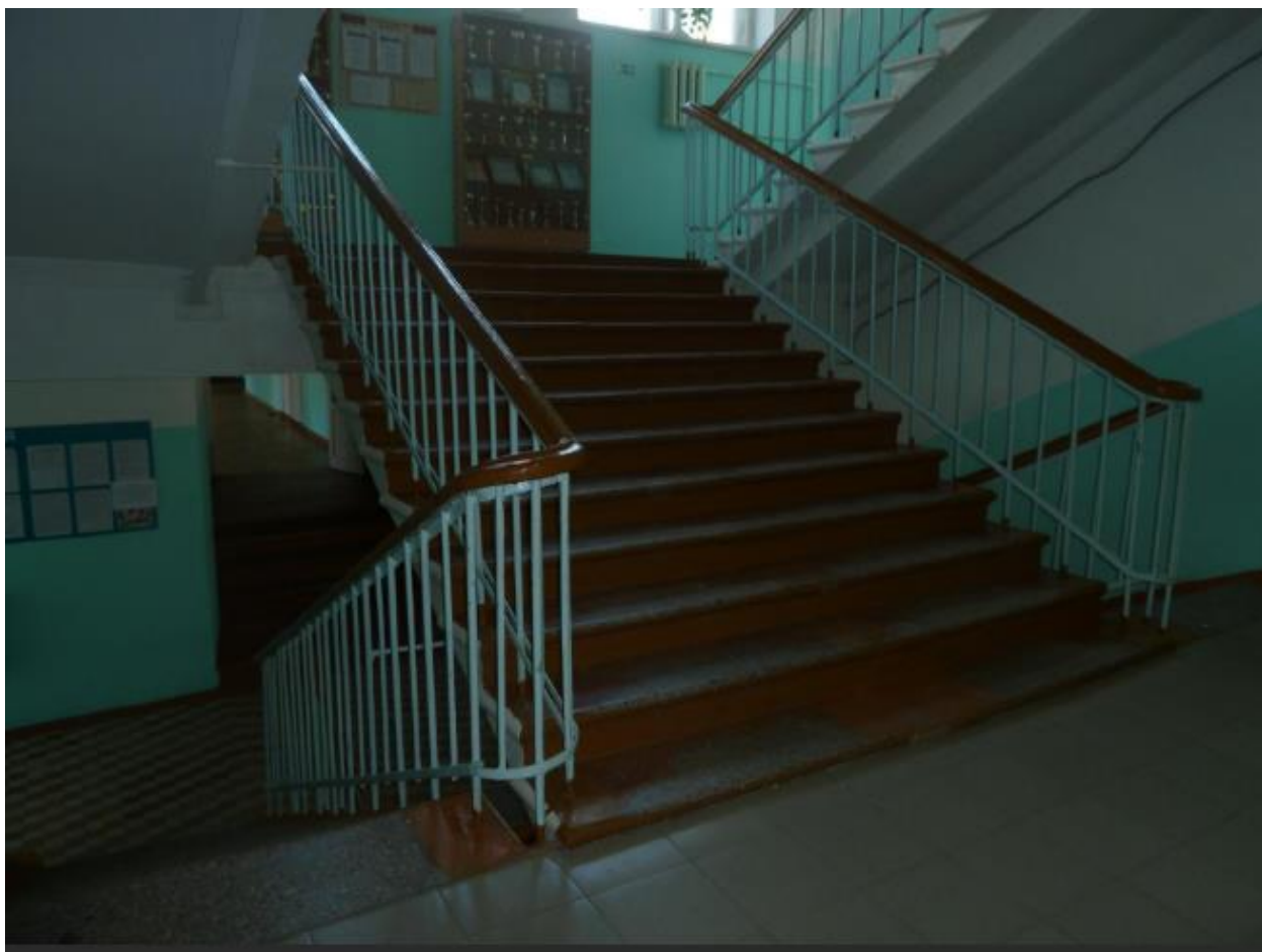
Рисунок 10 - Внутренняя лестница , размещенная в лестничной клетке
