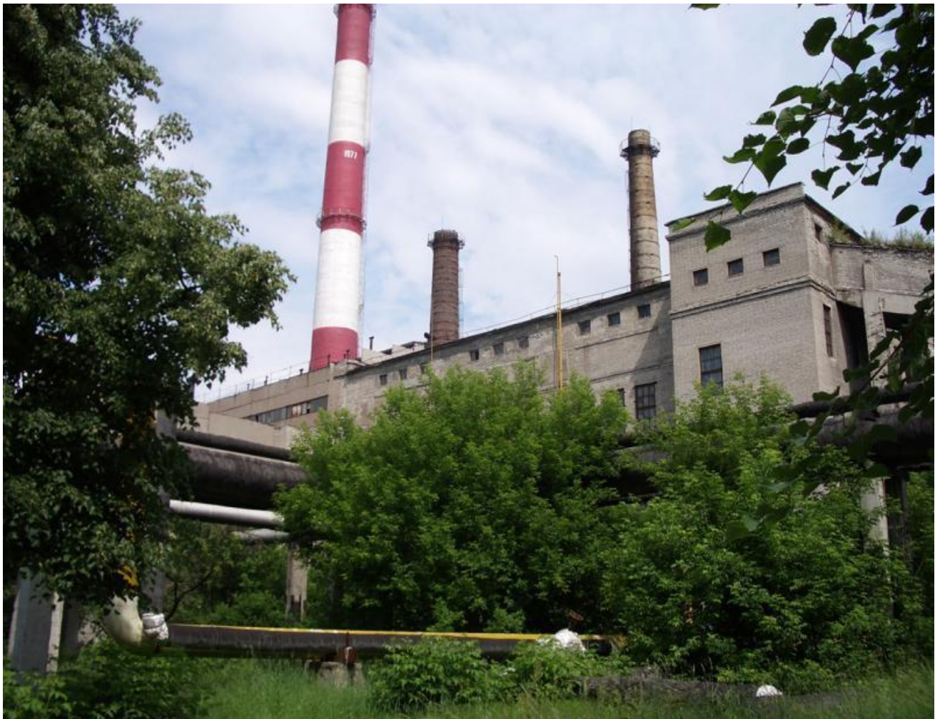
Рисунок 4.1 – Внешний вид дымовой трубы
