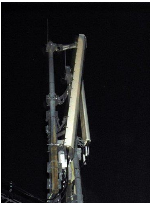
Рисунок 2 – Двухсекторная базовая станция LTE
