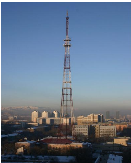
Рисунок 4.2 - Антенно-мачтовое сооружение телеканала «Казахстан». Высота 192 м.
