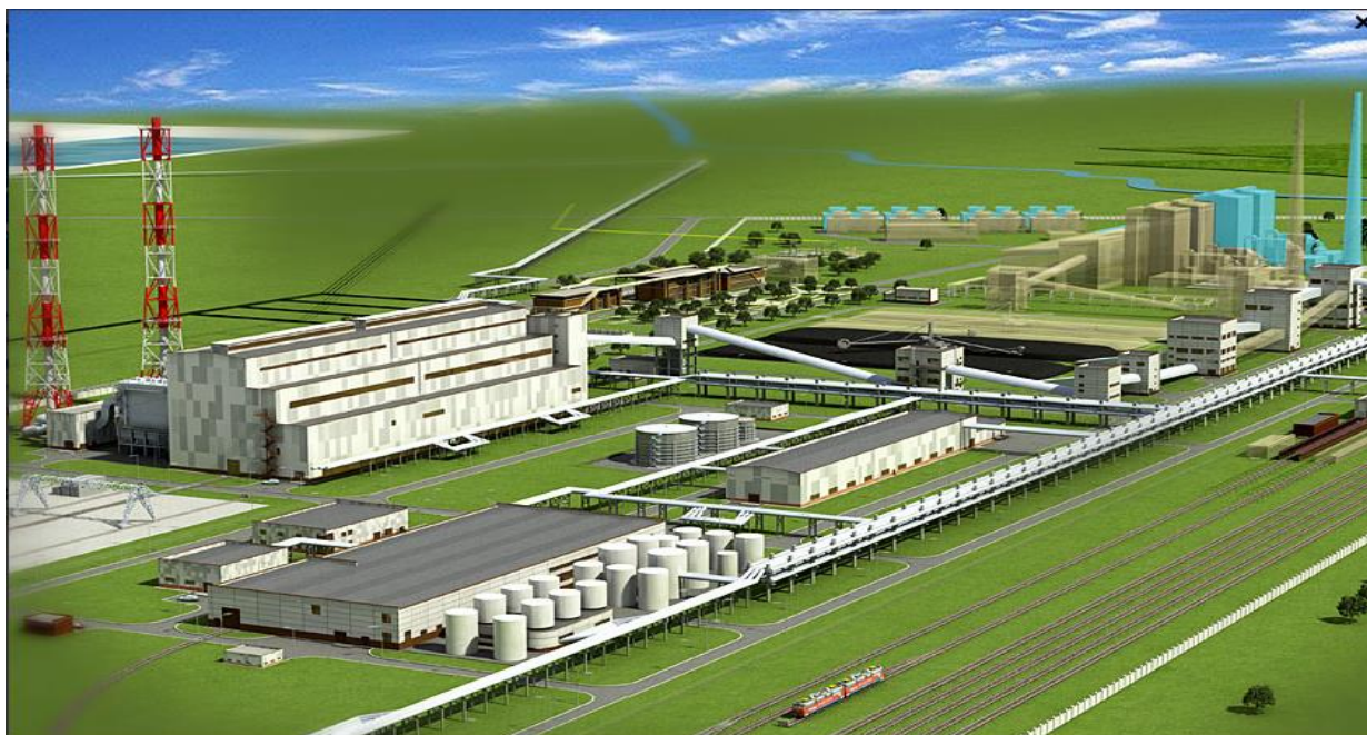
Рисунок 1 – Строительство ТЭЦ-3 в городе Астане
