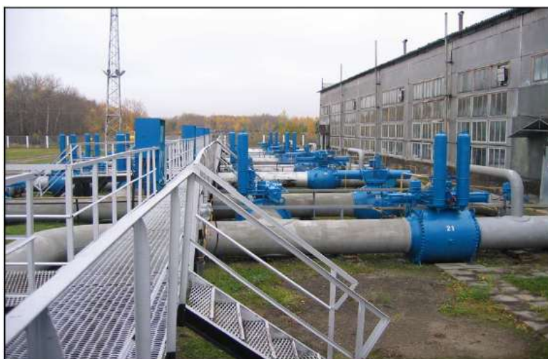
Рисунок 1.4 – Технологические трубопроводы КС
