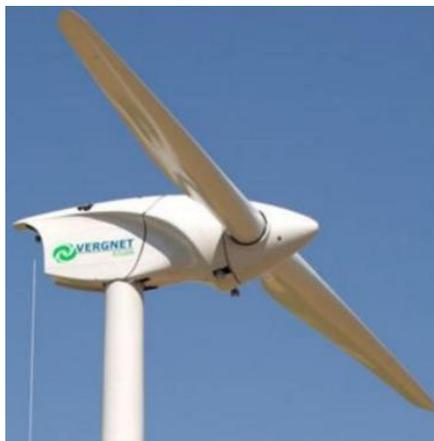
Рисунок 1.18 – Двухлопастной ветрогенератор
