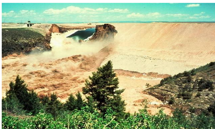
Рисунок 6 – Разрушение грунтовой плотины переливом воды
