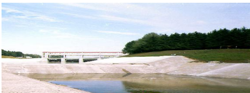
Рисунок 24 - Общий вид плотины на р.Биен
