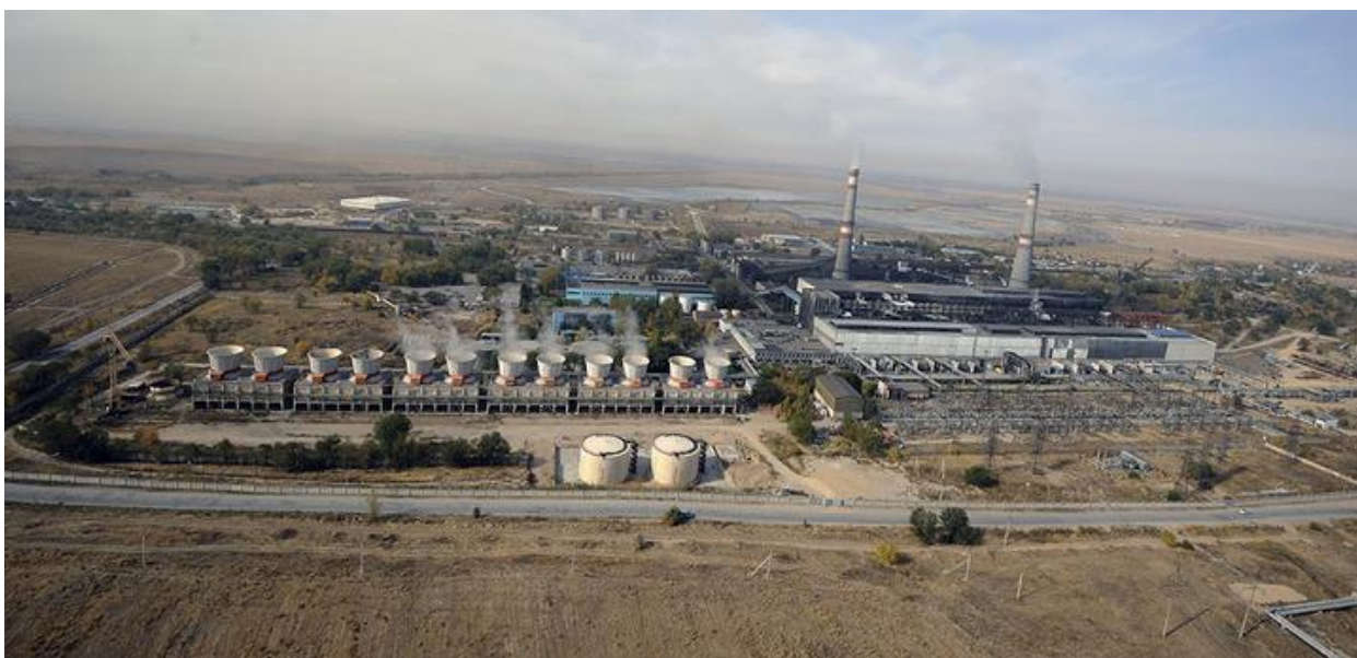
Рисунок 1.1 Общий вид ТЭЦ-2 АО «АлЭС»
