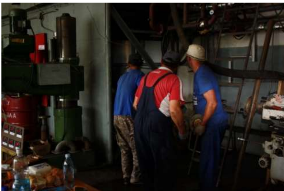
Рис. 3.2 – Процесс замены теплообменника ПВ-89*3 с гладкими трубами на витые
